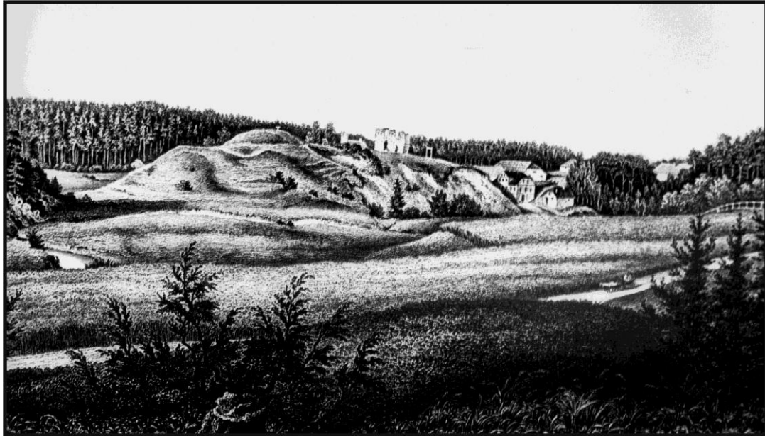
5. att. Tērvetes pilskalns. (Bruņinieku mūra pils pilsdrupas pilskalna nogāzē).
