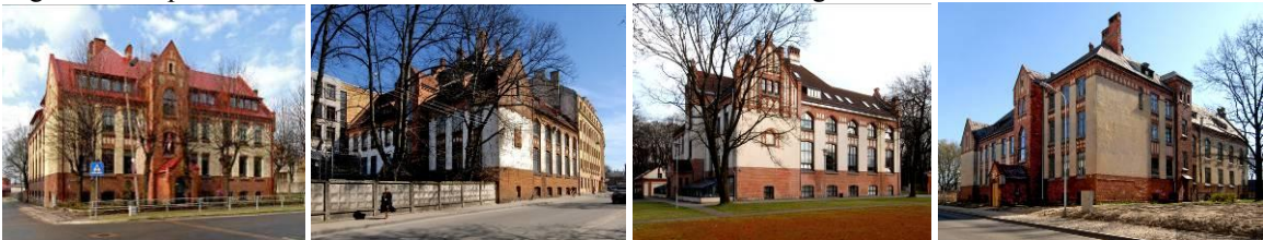
Rīga. Pilsētas pamatskola Patversmes ielā 20. 1912–1913. R. Šmēlings.
