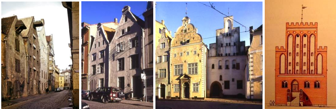
Rīga. Miesnieku ielas apbūve.
