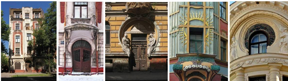
Rīga. Ģimes nams ar veikaliem Tallinas ielā 23. 1902. K. Pēkšēns, E. Laube Kopskats un fasādes fragments.
