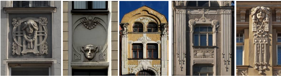
Rīga. Īres nams Brīvības ielā 110. 1902. J. Alksnis. Fasādes fragments.
