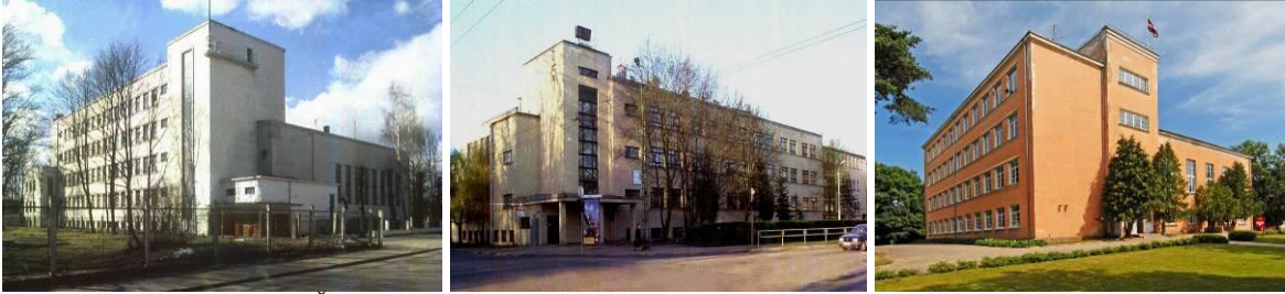
Rīga. Pilsētas pamatskola Čiekurkalna 1. garajā līnijā 53. 1933–1935. A. Grīnbergs.
