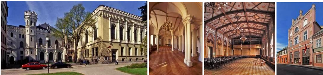
Rīga. Mazā Ģilde Amatu ielā 3/5 (1864–1866, J. D. Felsko) un Lielā Ģilde Amatu ielā 6 (1853–1859, K. Beine, H. Šēls)
