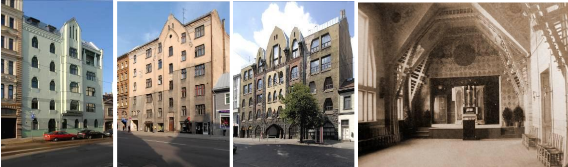
Rīga. Īres nams Lāčplēša ielā 4. 1905. K. Pēkšēns.
