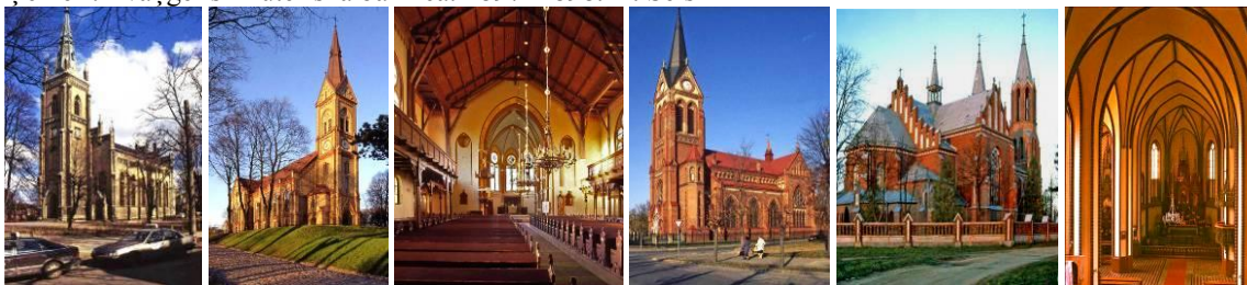
Rīga. Svētā Pāvila baznīca. 1885–1887. G. un H. Hilbigi. Rīga. Lutera baznīca. 1888. J. Kohs. Kopskats un telpne. Jelgava. Svētā Jura Romas katoļu baznīca. 1906. E. Strandmanis. Līksna. Svētās Sirds Romas katoļu baznīca. 1909–1912. Kopskats un telpne.
