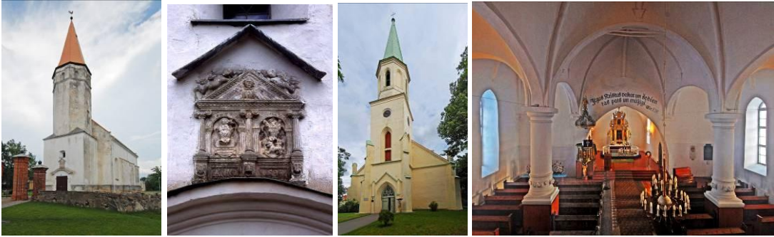
Nereta. Luterāņu baznīca. 1584–1593. Kopskats un edikula rietumu fasādē. Kuldīga. Svētās Katrīnas baznīca. 1655–1672. Rietumu fasāde un telpne.
