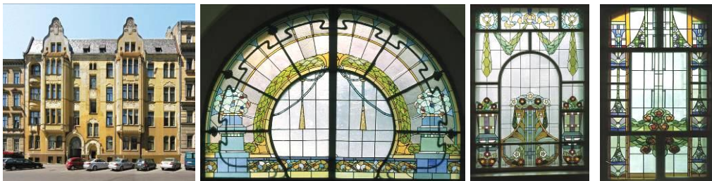
Rīga. Īres nams Baznīcas ielā 5. 1907. F. Šefels. Kopskats, vitrāža virs caurbrauktuves un vitrāžas kāpņu telpā.
