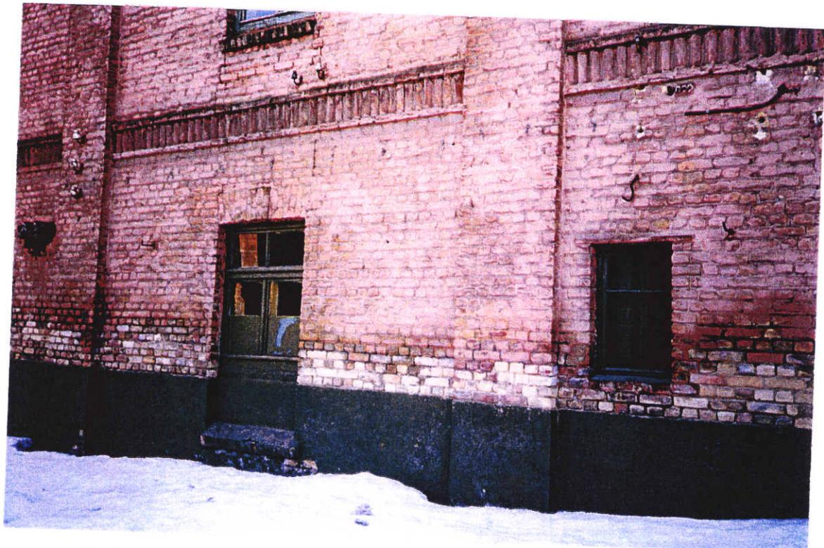
Ķieģeļu mūra korozija, ūdens migrācija, trūkst horizontālā pamatu hidroizolācija, sāļu ( $\text{NaCl}$ ) veidošanās (1999.g. Ganību dambī).
