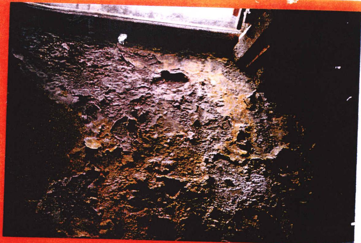
Rīgas pils torna iekšējā apmetuma korozija, 430 telpā ( $\text{SO}_4^{2-}$  konc. 6.5%).
